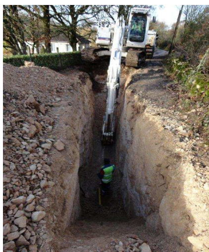
Travaux d'assainissement de Combe Brunet
