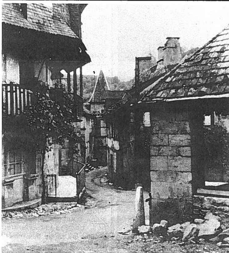
Rue Commandant Charolais - Halle de Turenne démolie en novembre 1952
